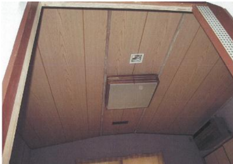
(和室の天井及び壁)
