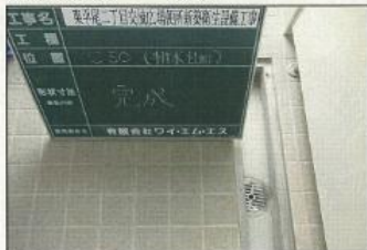
排水設備:屋内 (完成)
